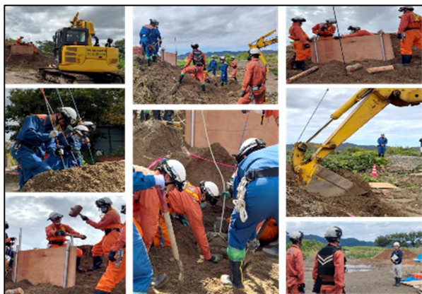
【建設業者との訓練の様子】
