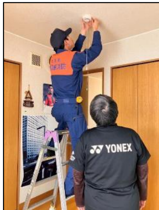
【取り替え作業の様子】
