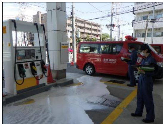
【固定泡消火設備の確認状況】
