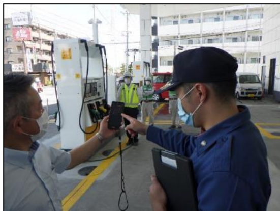
【タブレット型制御機器の確認状況】
