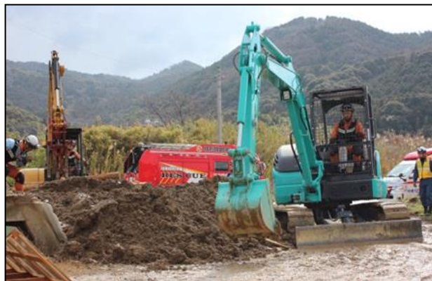
【重機を活用した土砂埋没救助訓練の様子】
