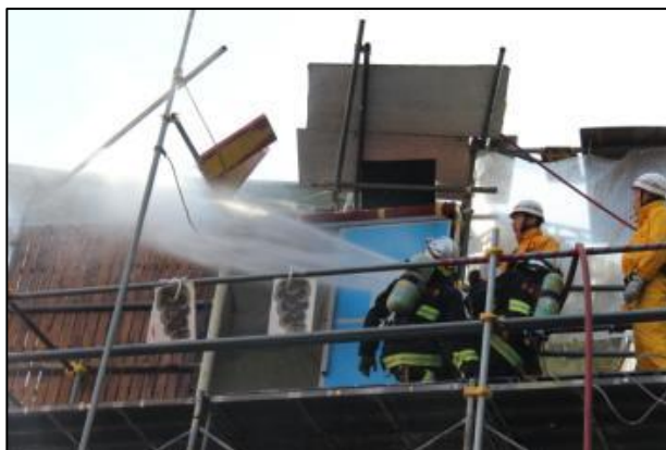
【高所での放水の様子】
