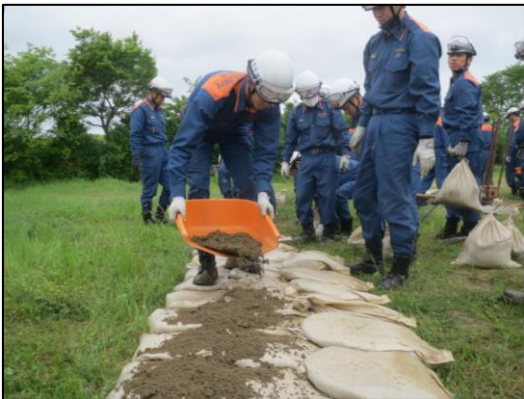
【積み土のう工法】
