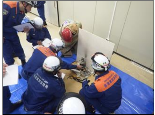
【コンセント付近を発掘する様子】
