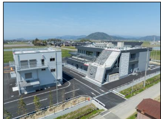
【東浅井消防署新庁舎】
