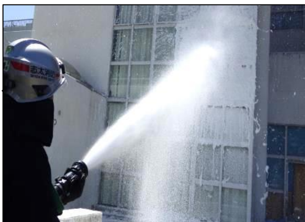
【CAFS（圧縮空気泡消火システム）放射の様子】
