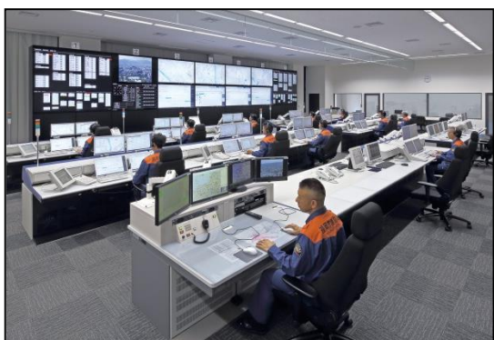
【福岡都市圏消防共同指令センター内の様子】
