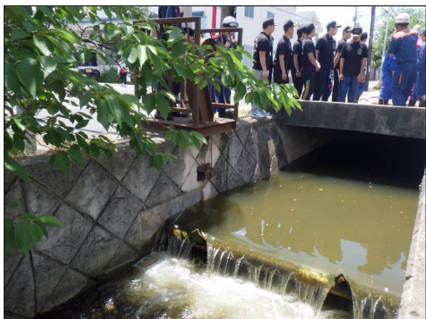
【河川堰の様子】
