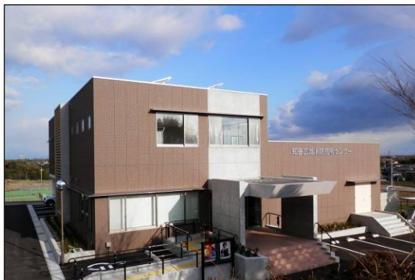
【センター建屋外観】
