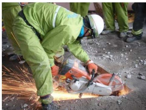
【エンジンカッターによる破壊状況】
