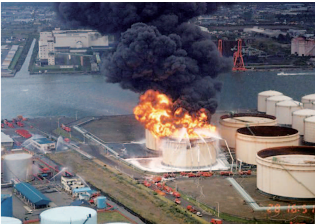
十勝沖地震によるタンク火災
